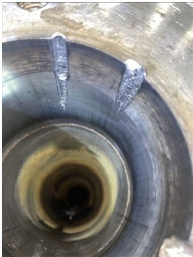
2.5.1.3 AF HP Bore Damage
